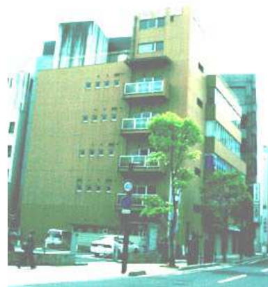
↑ 三洋苑第 1 ビル外観
